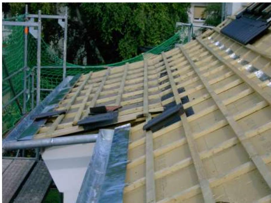
Holzweichfaserplatten sind eine empfehlenswerte Alternative zur Unterspannbahn: Sie sind stabiler und bieten einen zusätzlichen Dämmeffekt.
