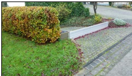
Abbildung 13: Beispiele von Objektschutzmaßnahmen (mobile Steckelemente, Dammbalkensysteme, Abdichtungen)
