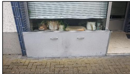
Abbildung 13: Beispiele von Objektschutzmaßnahmen (mobile Steckelemente, Dammbalkensysteme, Abdichtungen)
