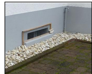
Abbildung 14: Beispiele von Objektschutzmaßnahmen (Überbogen, Geländemodellierungen, Aufkantung am Kellerfenster)
