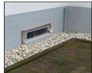
Abbildung 14: Beispiele von Objektschutzmaßnahmen (Überbogen, Geländemodellierungen, Aufkantung am Kellerfenster)
